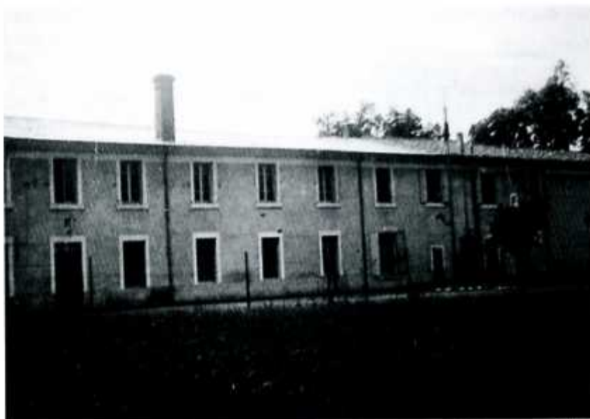
Bâtiment sud-ouest (n° 5 du plan) où se trouvaient les chambres des internés résidant au camp. (photo d'époque, coll. F. Jonas)
